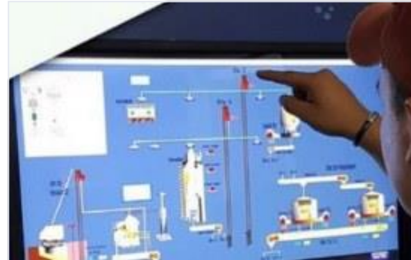
Supervisório em tela
