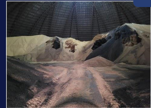
Massa deteriorada dentro do silo
