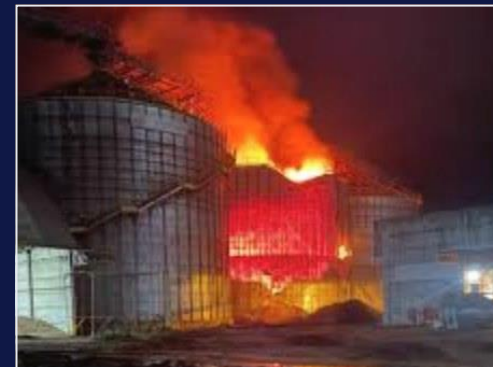
Foco de incêndio em unidade
